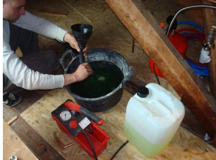
Remplissage du circuit avec de l'eau glycolée.
