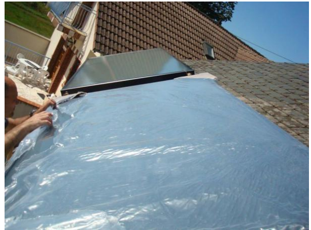
10.Mise en place du second capteur
