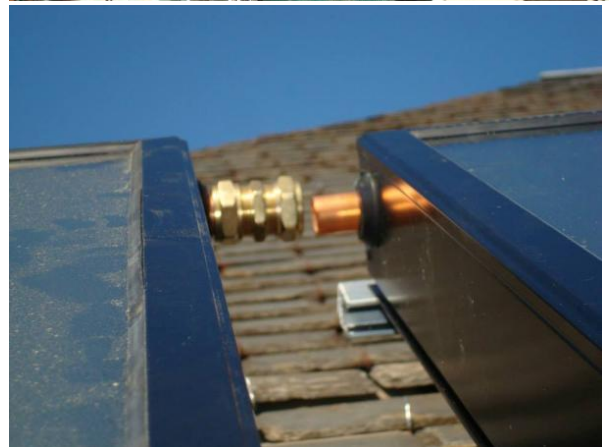
11.Raccordement inter-panneaux. Les deux capteurs sont branchés en série, c'est à dire que l'eau froide entre en partie basse du panneau gauche et sort en partie haute du panneau droit
