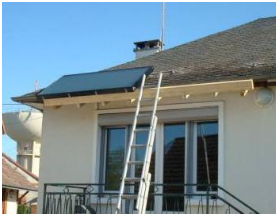
7.Mise en place du premier capteur
