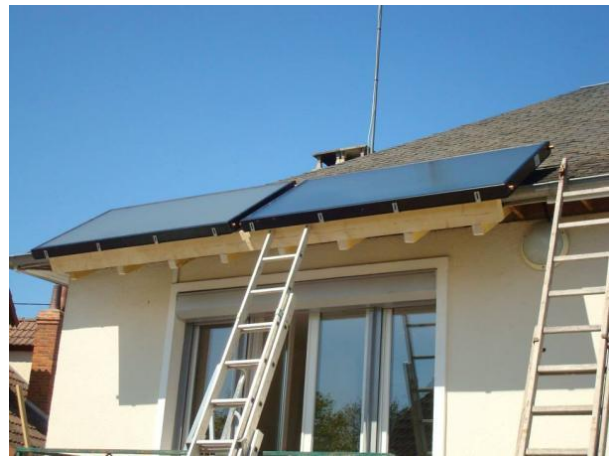
10.Mise en place du second capteur
