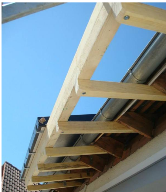
9.L'installation vue du dessous
