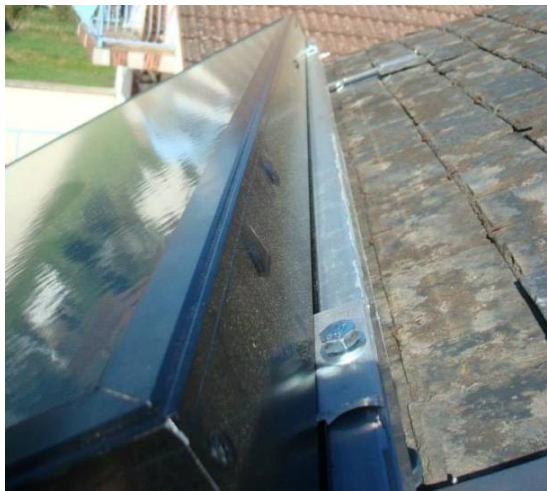
8.Système de fixation en partie supérieure
